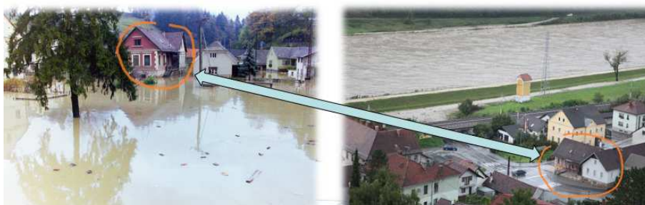
Slika 3: Zgrajen akumulacijski bazen je Sevnici zagotovil poplavno varnost.
