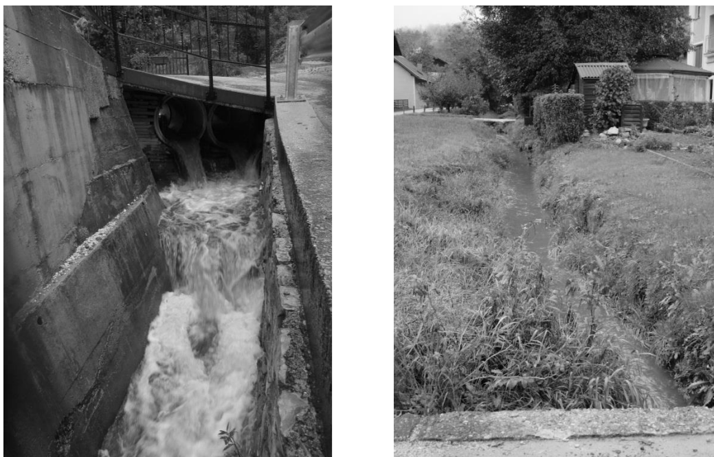
Slika 18 Primera stanja vodnih teles v občini Log – Dragomer: betonski zadrževalnik v obliki korita na Snežaku; melioracijski jarek v naselju (foto Kristina Klemen)
