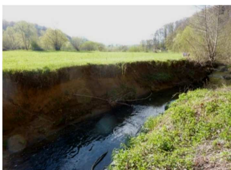
Slika 1 Erozija brežine - april 2012 (foto: arhiv ZRSVN)
