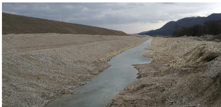
Slika 3 Drenažni kanal vzdolž nasipov, ki se ureja kot habitat za reofilne vrste rib
