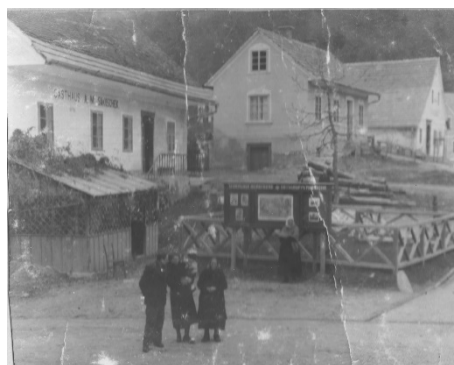
Slika 8 Vodni zbiralnik in Pilštanj nekoč. Lesena ograja je varovala cisterno pred živino.
