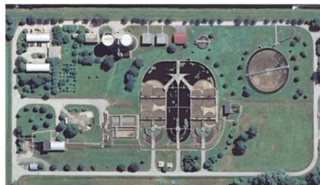
Slika 3 Porušitev polovice, po načrtu na sliki 2 zgrajene čistilne naprave. Kasneje so tudi to napravo porušili in na istem mestu zgradili že tretjo napravo za nitrifikacijo in denitrifikacijo, za kar je bila prva že 1980 zgrajena.
